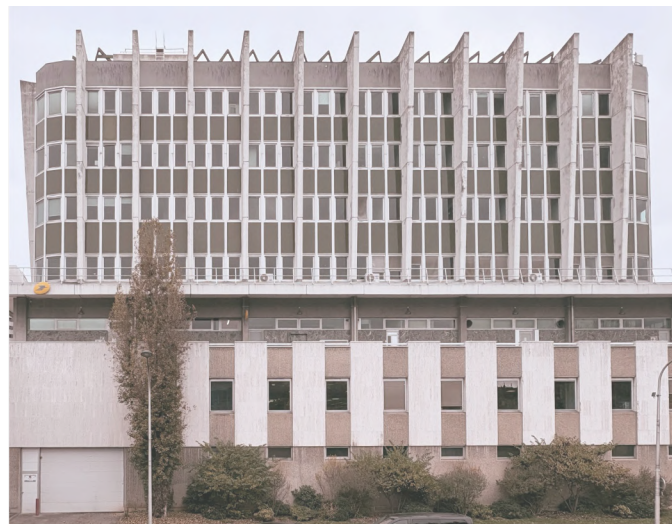
Façade Sud du bâtiment
